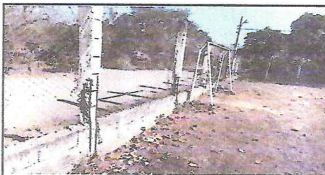
Foto 3: Reparación de muro perimetral block con tubo hg y malla galvanizada
